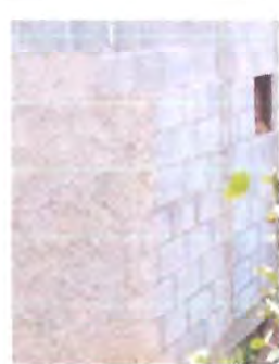
REPELLO Y CERNIDO EN PAREDES DE COCINA
