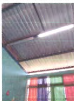
REPARACIÓN DE SISTEMA ELÉCTRICO Reparación de instalaciones eléctricas, 2 lamparas, 2 tomacorrientes, 1 apagador con ducto y cableado
