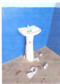
SERVICIOS SANITARIOS Y SUS ACCESORIOS Mantenimiento a lavamanos, cambio de sifon, chorro Sustitucion 2 sanitarios en mal estado
